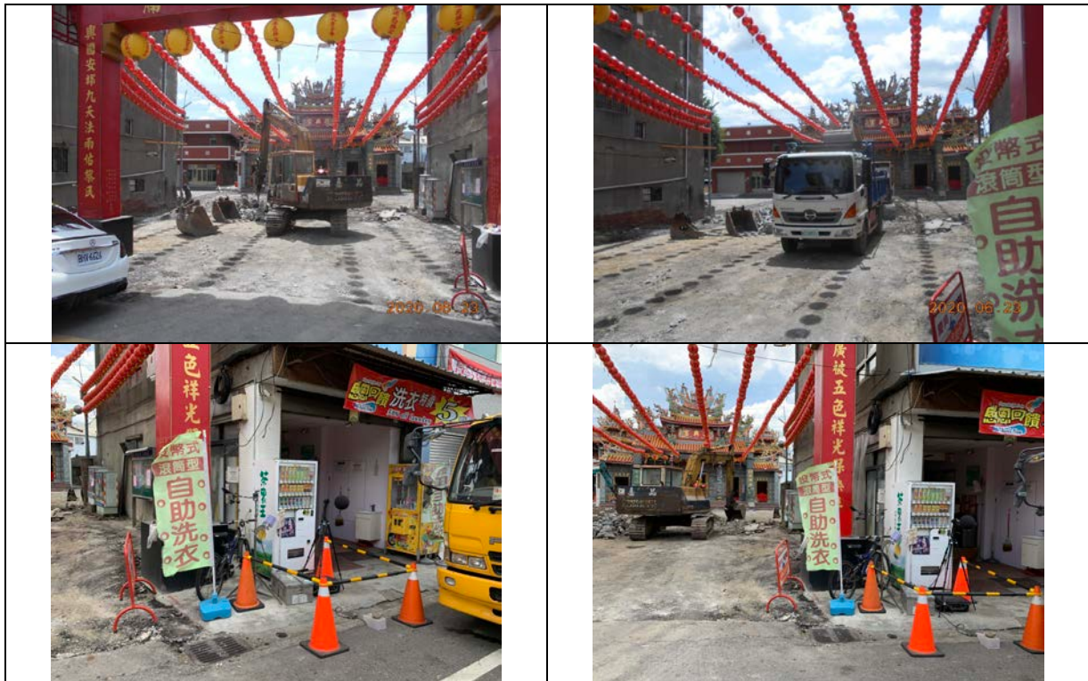
圖 2.5-4、本季慈興宮前廣場施工現況
