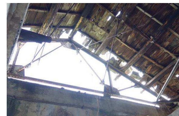
【照 5-4】芬克式 (Fink Truss) 鋼構屋架
