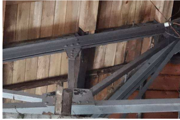
【照 5-5】屋架鋼構件以鋼板及鉚釘接合
