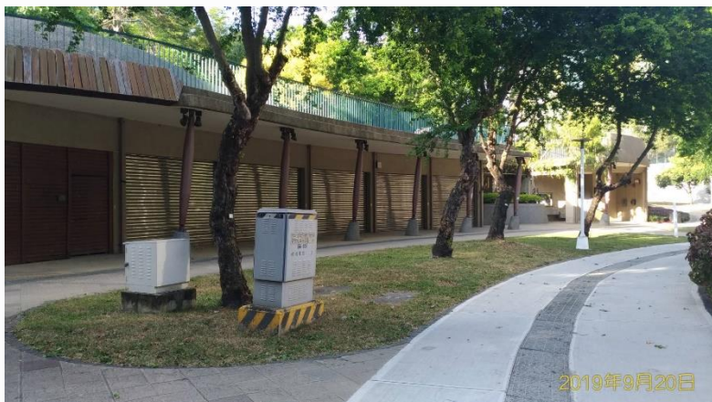
管理室前走道
