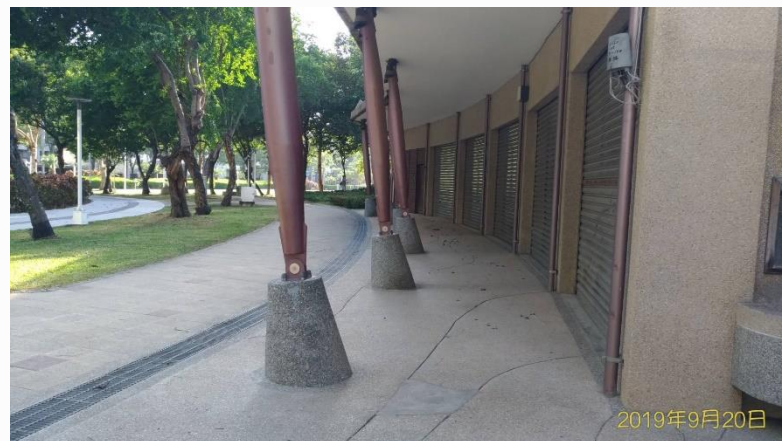
管理室前走道
