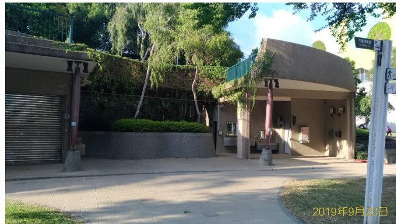
女廁、無障礙廁所及管理室旁廣場
