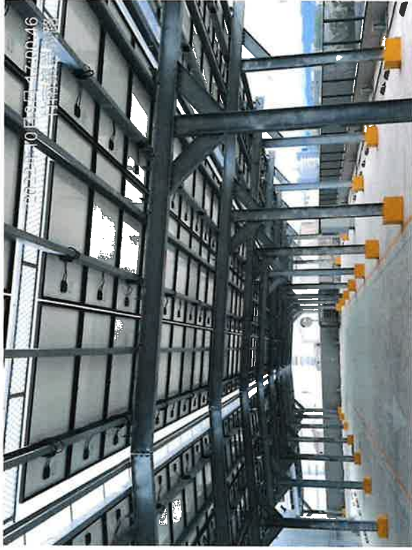
屋頂型鋼構示意圖
