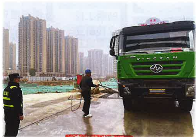
車輛離開工區沖洗(避免泥土附著)
