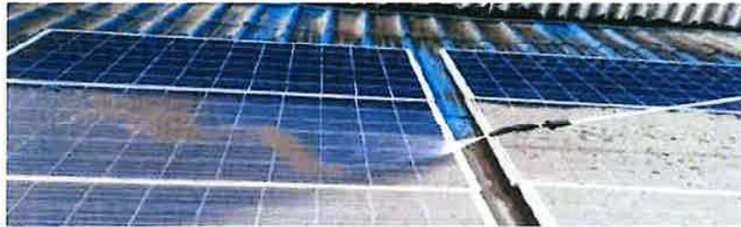
圖 2-5 太陽光電模組板清潔示意圖
