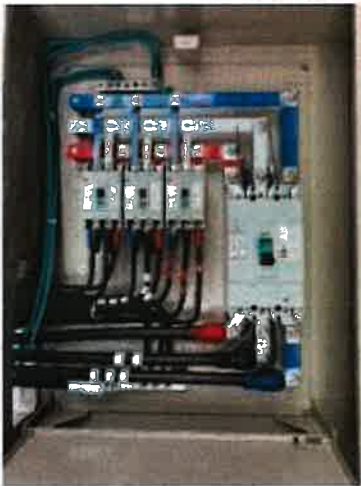
加裝電驛保護開關， 短路時自動跳脫。
