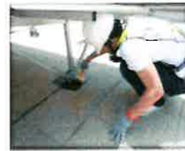
防水工程 補強，避 免漏水問 題產生
