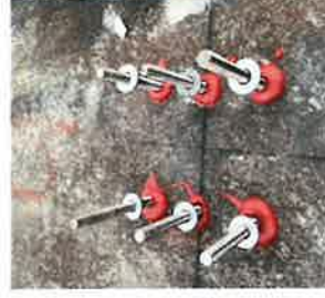
植筋膠填滿孔洞，插入牙條
