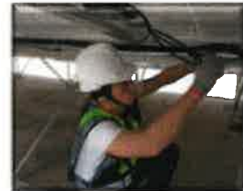
電路、電 箱定期檢 查，發現問 題立即排除
