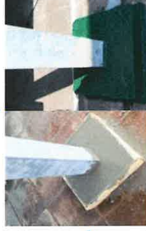
基礎座澆置、塗佈防水
