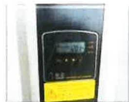
INVERTER 維修更換
