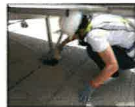
防水工程 補強，避 免漏水問 題產生
