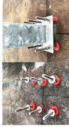
植筋膠填滿孔洞，插入牙條
