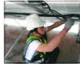
電路、電 箱定期檢 查，發現問 題立即排除
