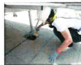
防水工程 補強，避 免漏水問 題產生
