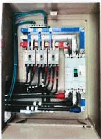
加裝電驛保護開關， 短路時自動跳脫。
