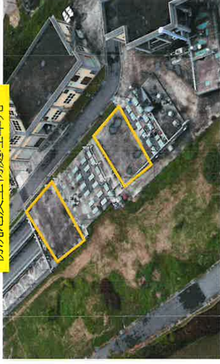
初沉池及生物處理單元
