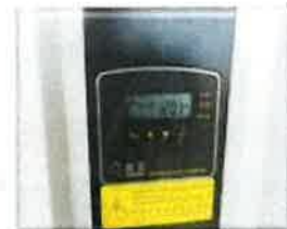
INVERTER 維修更換
