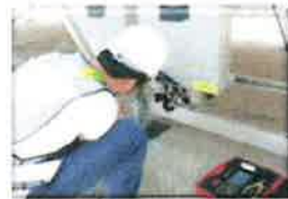
支撐架、螺絲、IN-VERTER 巡檢維修
