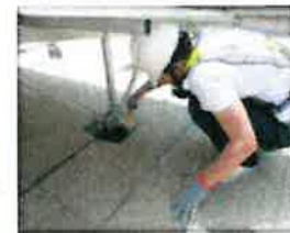
防水工程補強 ，避免漏水問題產生
