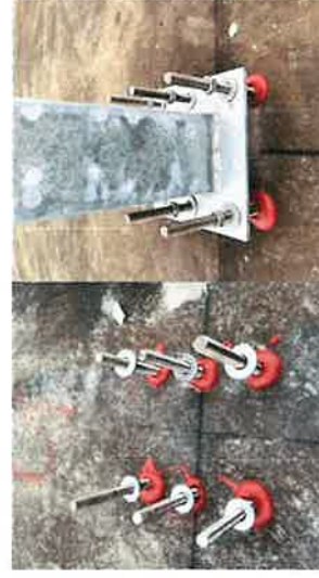
植筋膠填滿孔洞，插入牙條
