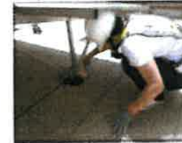
防水工程 補強，避 免漏水問 題產生
