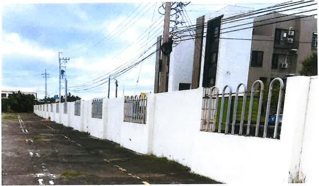
A-道路及住宅
