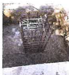
綁基礎鋼筋灌漿 綁基礎螺絲及基板
