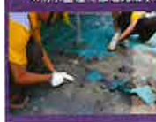
4. 防水工程補強避免漏水
