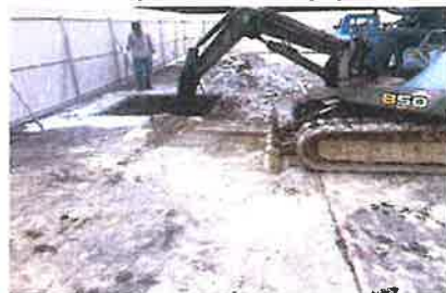
挖基礎洞(2m*2m)(深1.4m)
