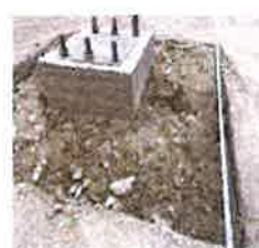
基座灌漿後回填，約 14天 後可立柱。 (養護到達水泥抗壓強度標準)
