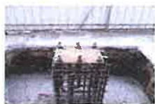
綁基礎鋼筋灌漿 綁基礎螺絲及基板
