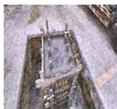
基座灌漿後回填，約 14天 後可立柱。 (養護到達水泥抗壓強度標準)
