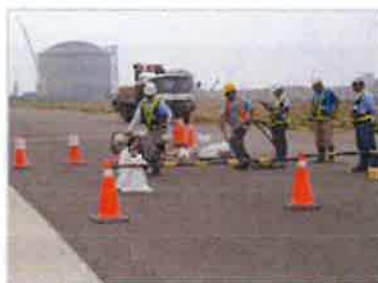
設置抽水設備
