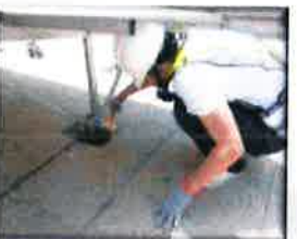
防水工程 補強，避 免漏水問 題產生
