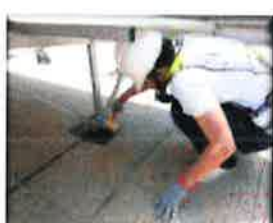
防水工程 補強，避 免漏水問 題產生
