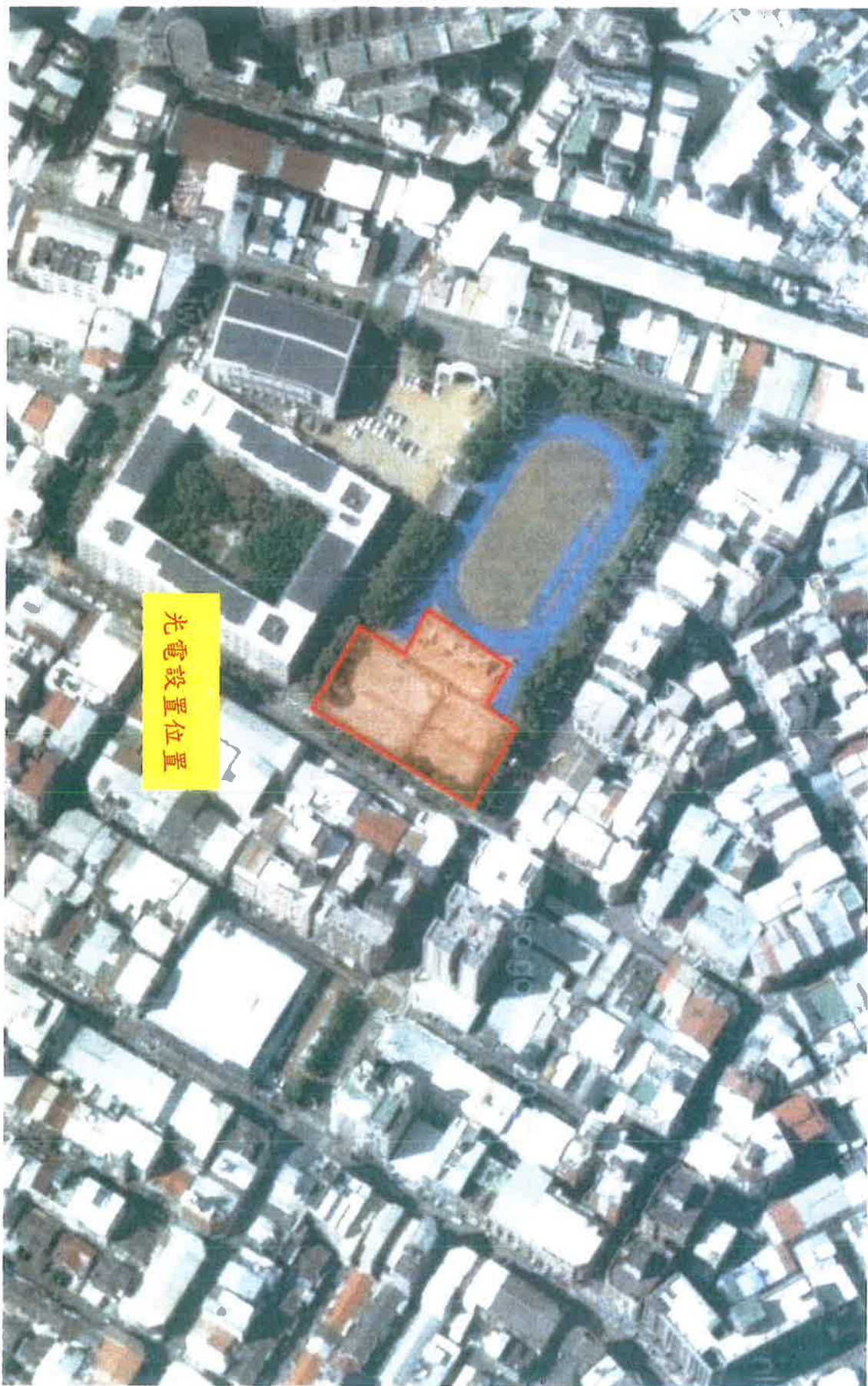
漢口國中-太陽光電設置位置
