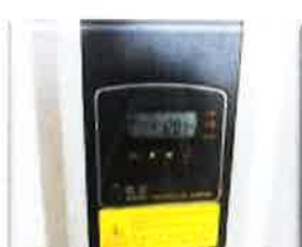
INVERTER 維修更換
